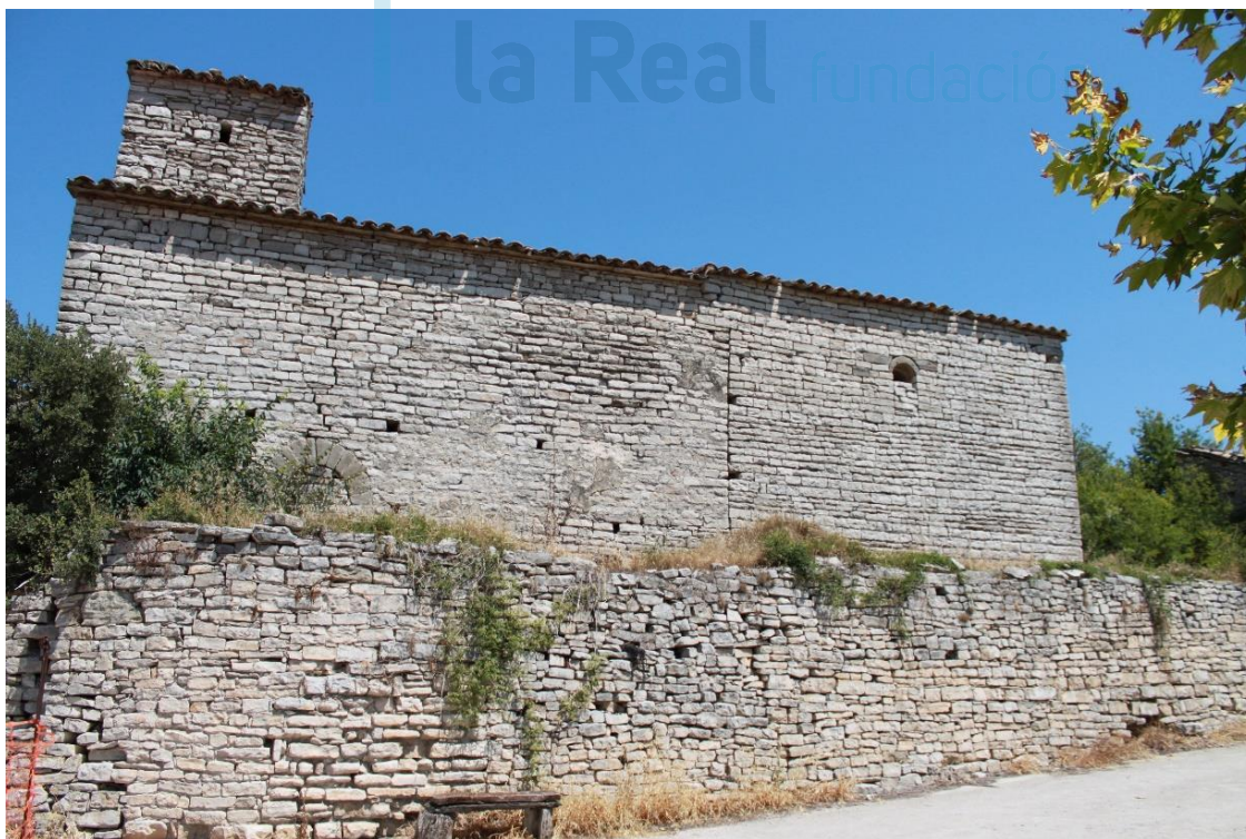
Exterior del muro sur
