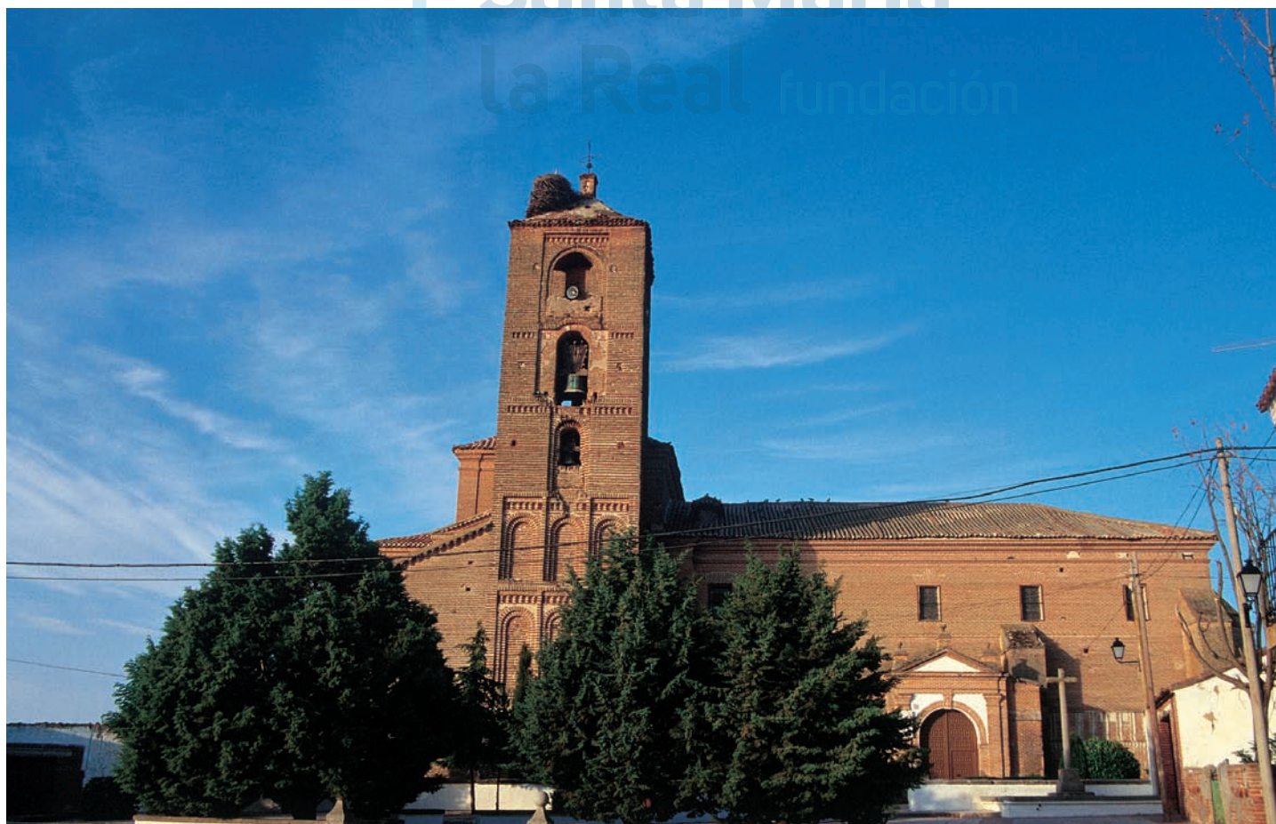
Exterior de la iglesia
