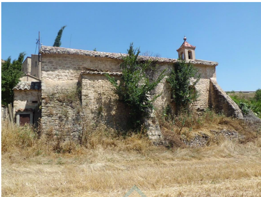
Vista exterior del muro sur
