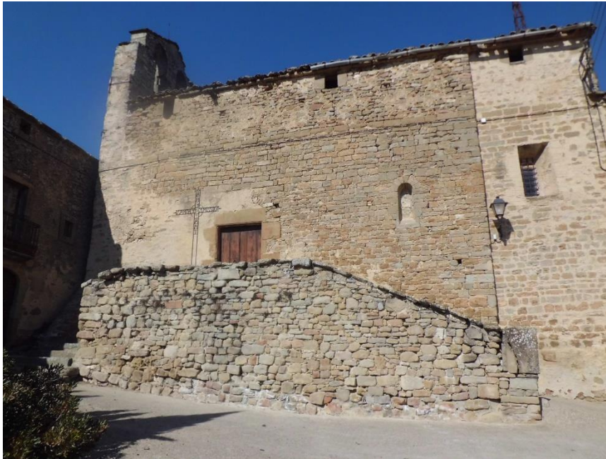
Vista exterior de muro sur
