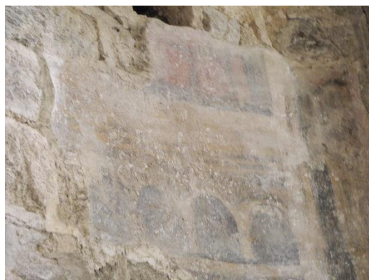
Restos de pintura mural
