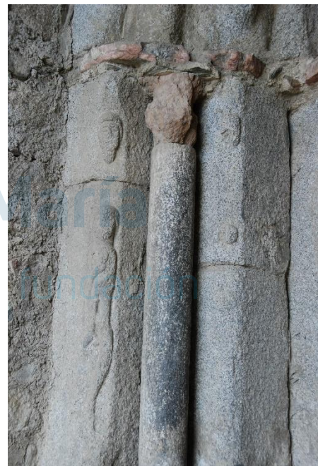
Detalle de la portada, jamba izquierda
