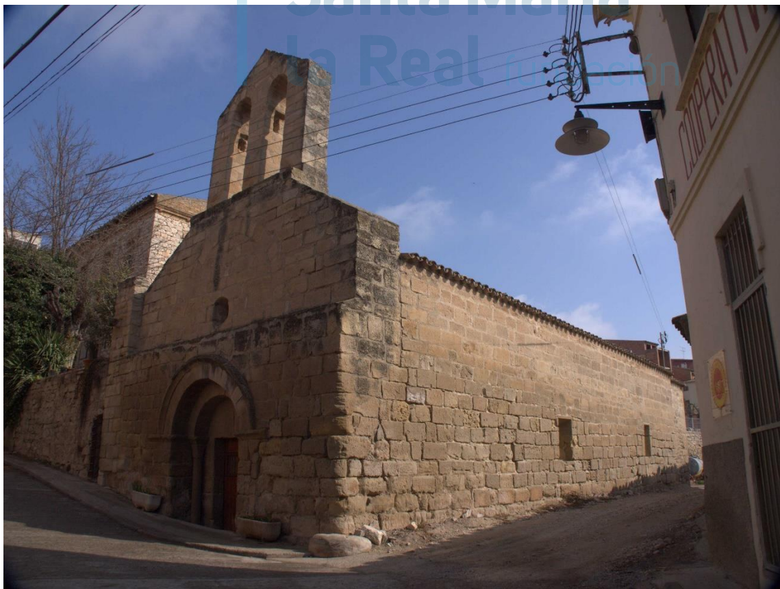
Fachada oeste y muro sur
