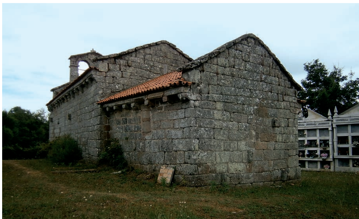
Vista desde el lado sureste
