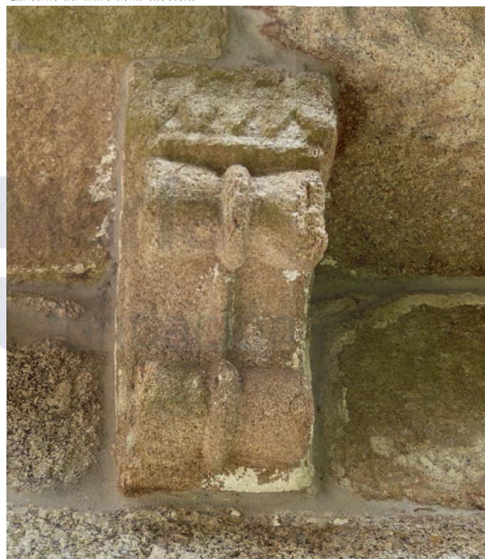
Canecillo del muro de la cabecera
