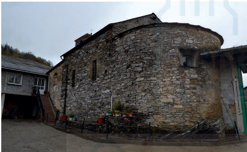
Vista general de la iglesia
