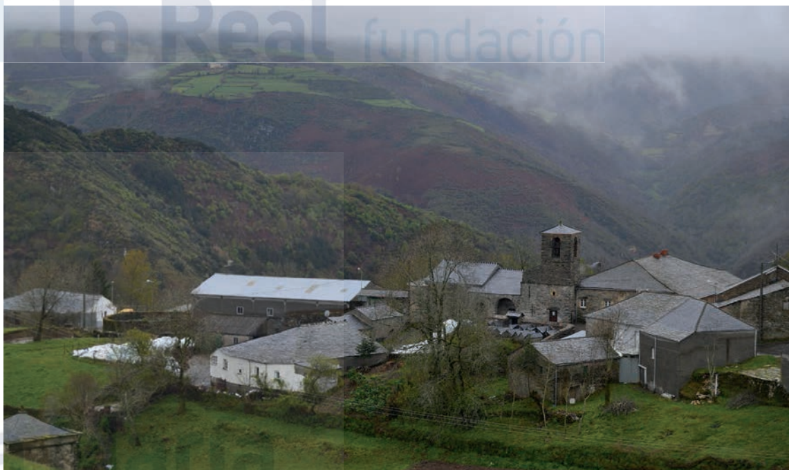
Vista del emplazamiento
