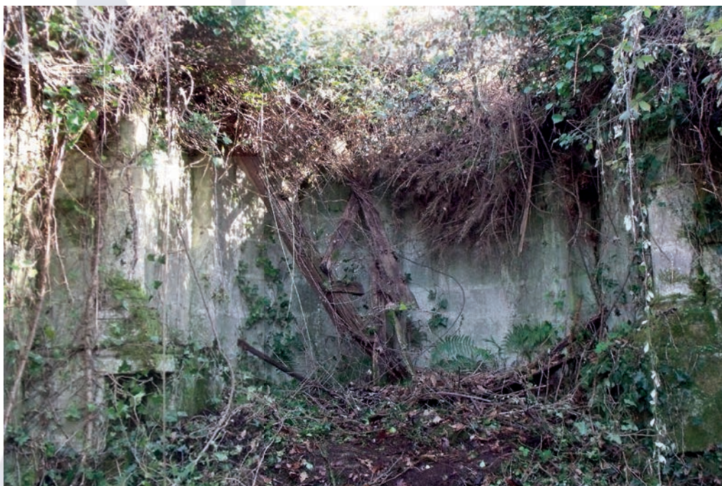
Restos del ábside
