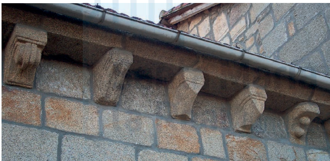
Alero norte del ábside
