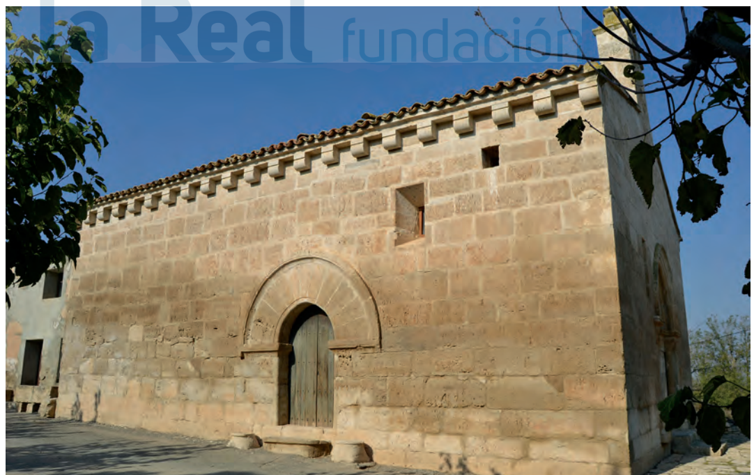
Vista del lado sur
