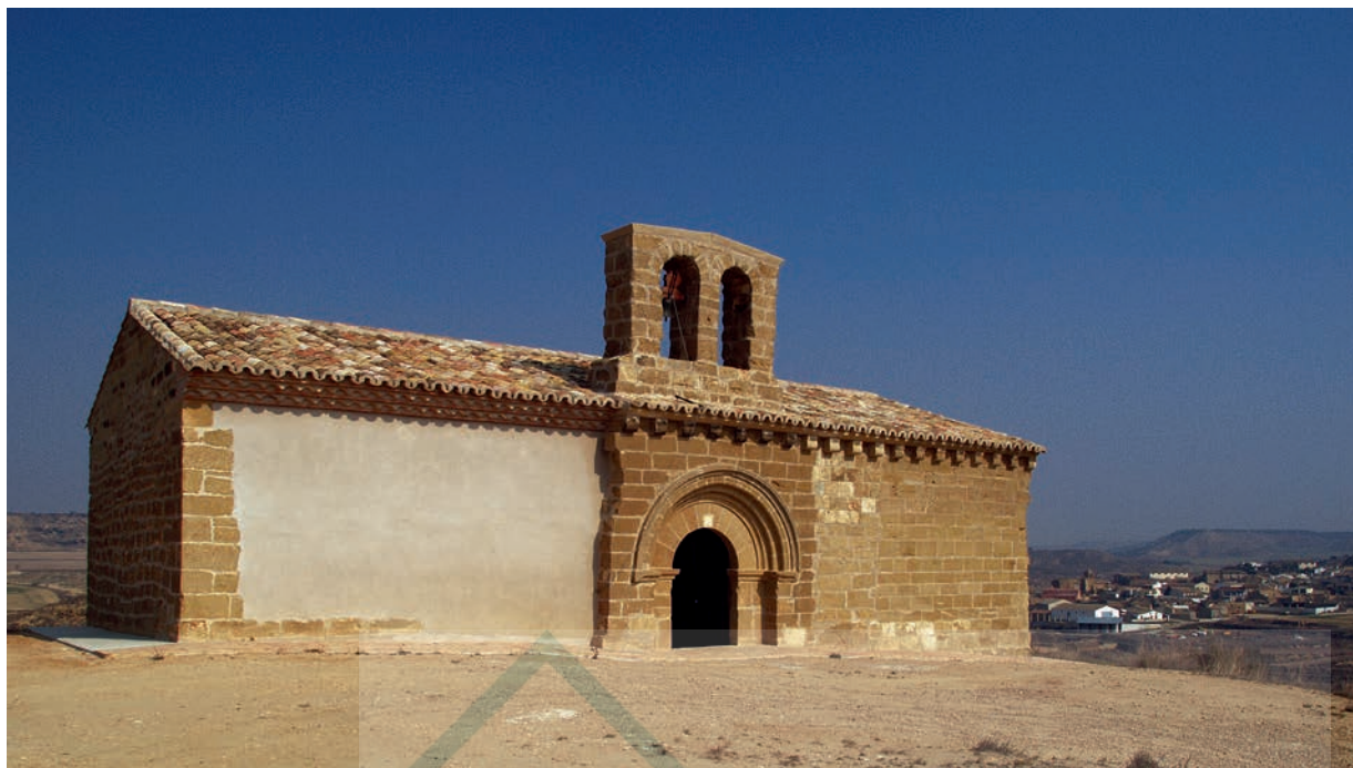
Muro sur y portada
