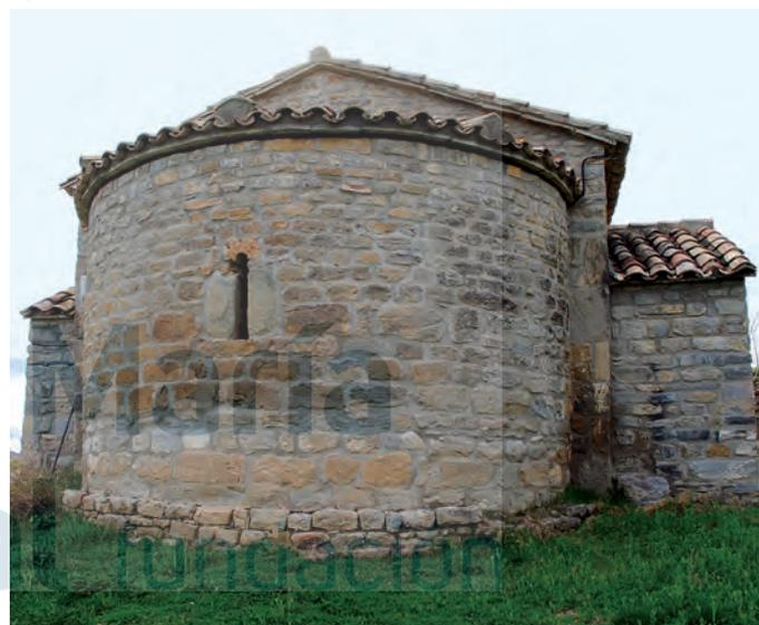
Se trata de una iglesia de nave única y cabecera de planta semicircular con dos capillas laterales de escaso desarrollo, portada en el muro sur y espadaña de doble hueco coronando el hastial. Aunque el aparejo se ha visto muy alterado por las obras de restauración, puede observarse en la parte que mantiene la fábrica original, con sillería poco trabajada y de tamaños muy irregulares. La espadaña fue rehecha en la restauración.
