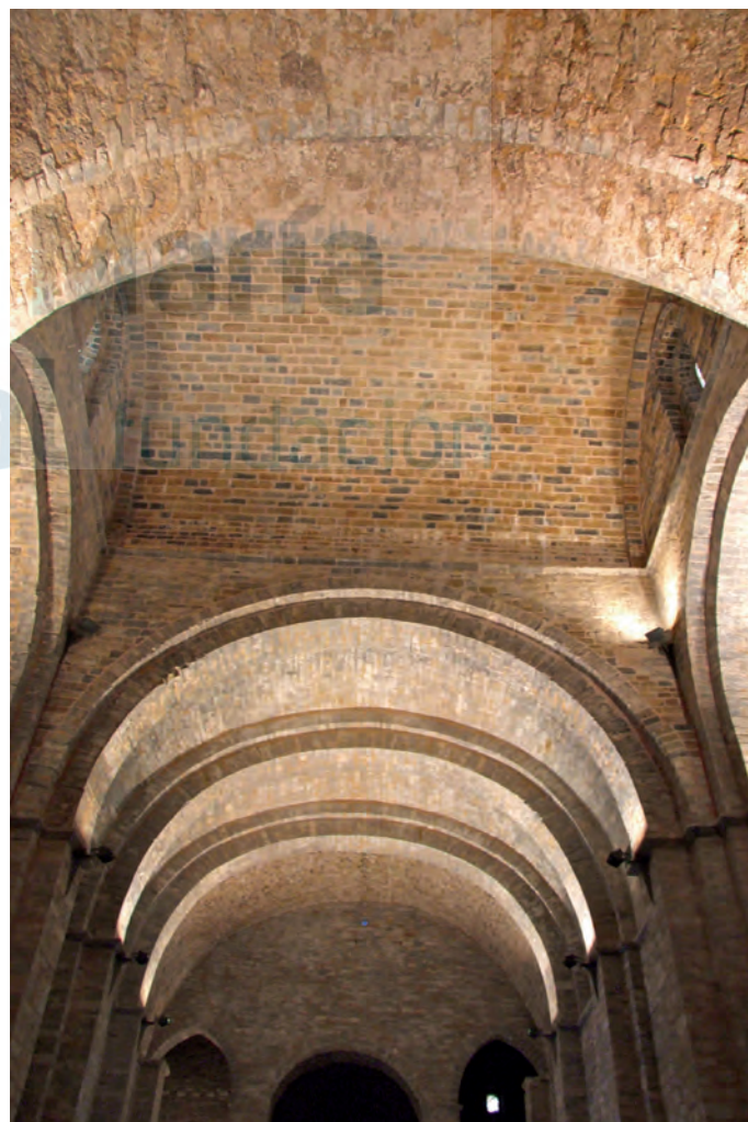
Bóvedas del crucero
