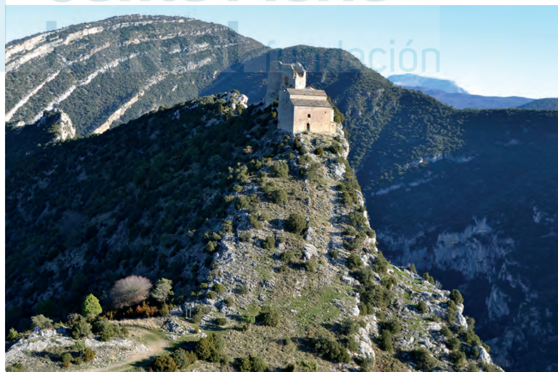
Vista del emplazamiento
