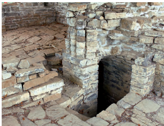
Iglesia alta. Escalera de acceso a la nave lateral
