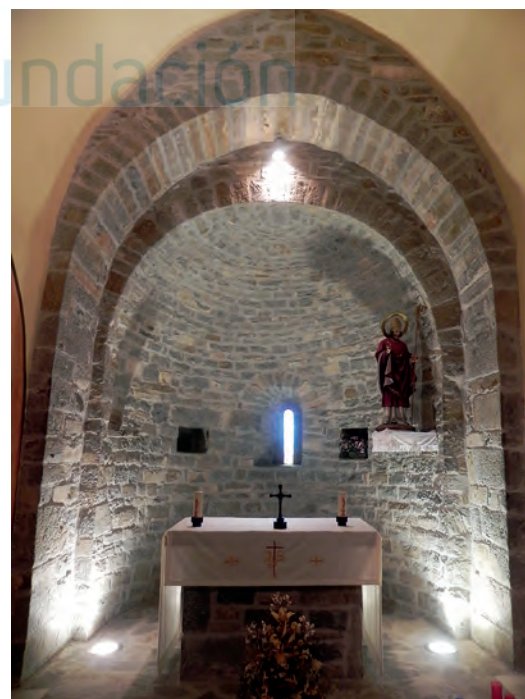
Interior del ábside
