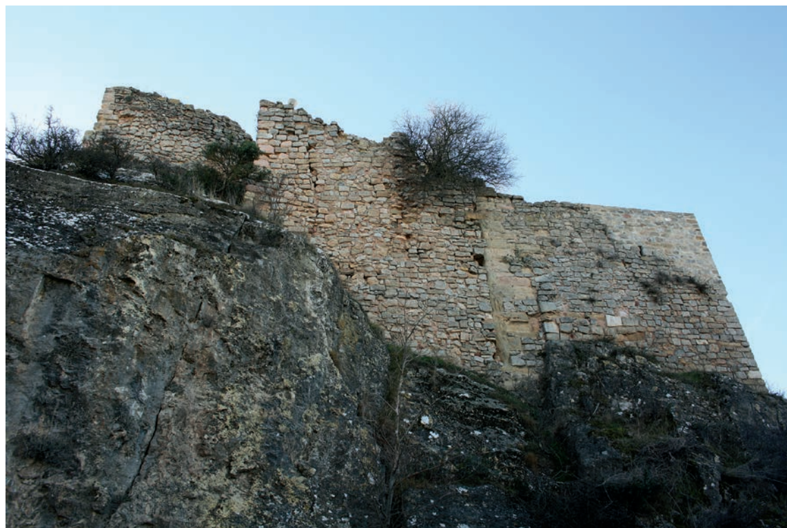
Vista exterior del muro norte
