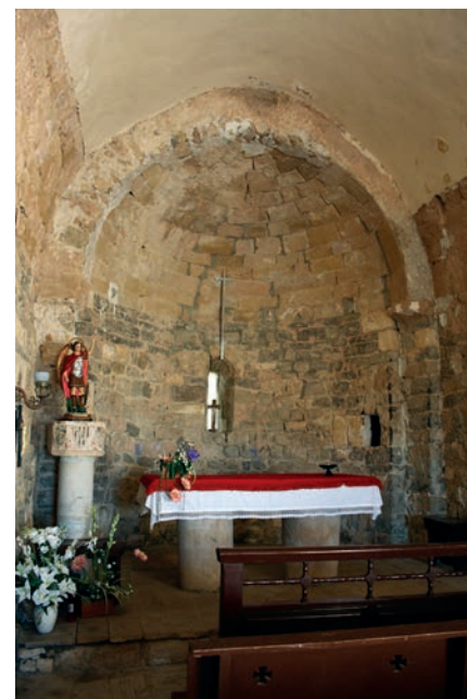
Interior del ábside
