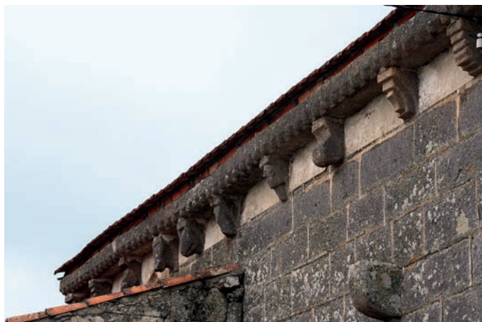
Canecillos del muro norte
