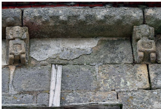
Canecillos del muro norte
