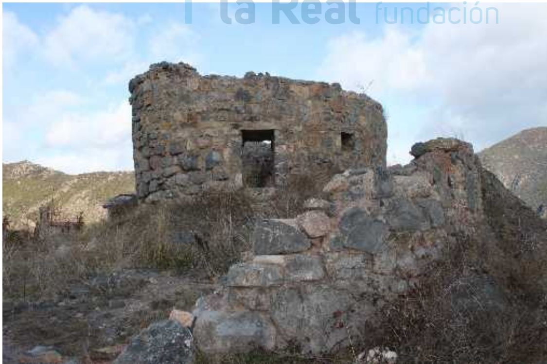
Restos de la torre
