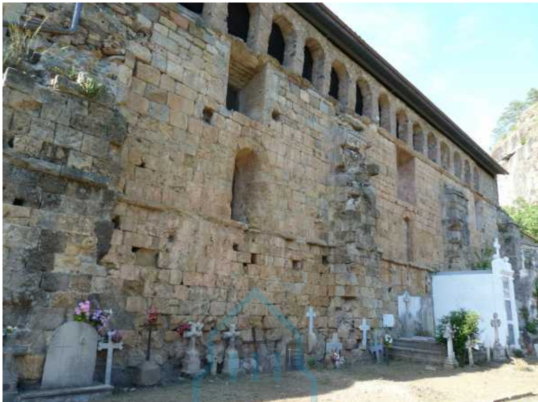
Vista exterior del muro sur
