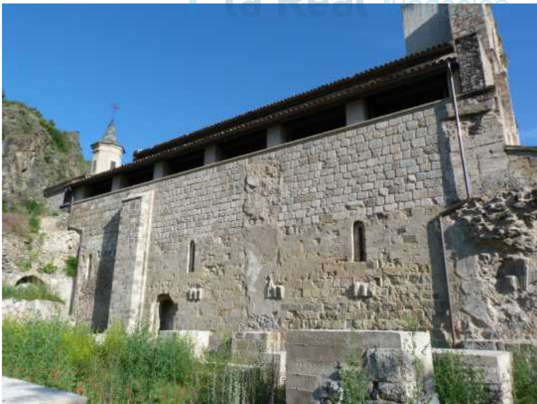
Vista exterior del muro norte
