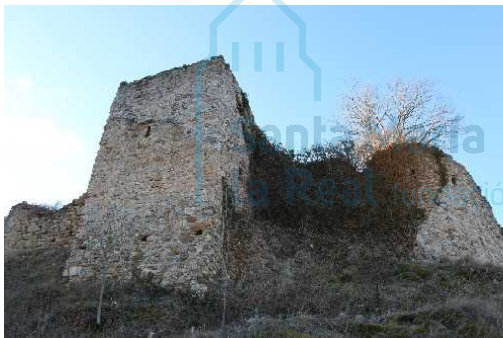
Vista general desde el noroeste
