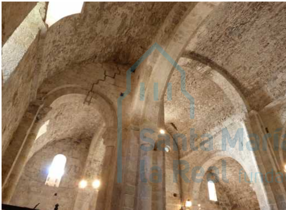
Vista interior del tramo occidental
