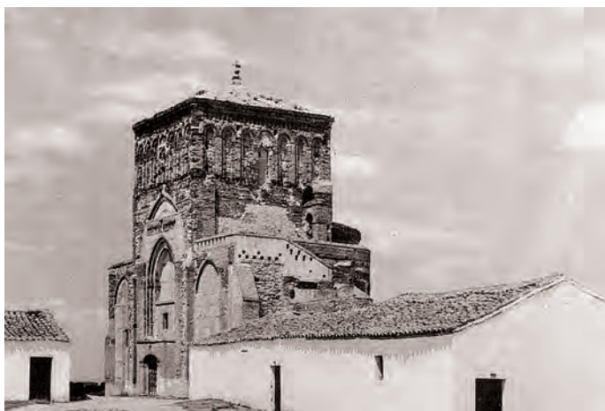
La Lugareja antes de la restauración, alrededor de 1910
