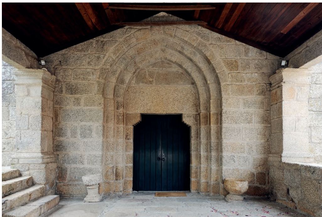
Fachada oeste. Portal
