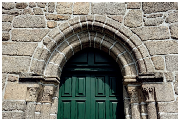
Detalhe do portal oeste
