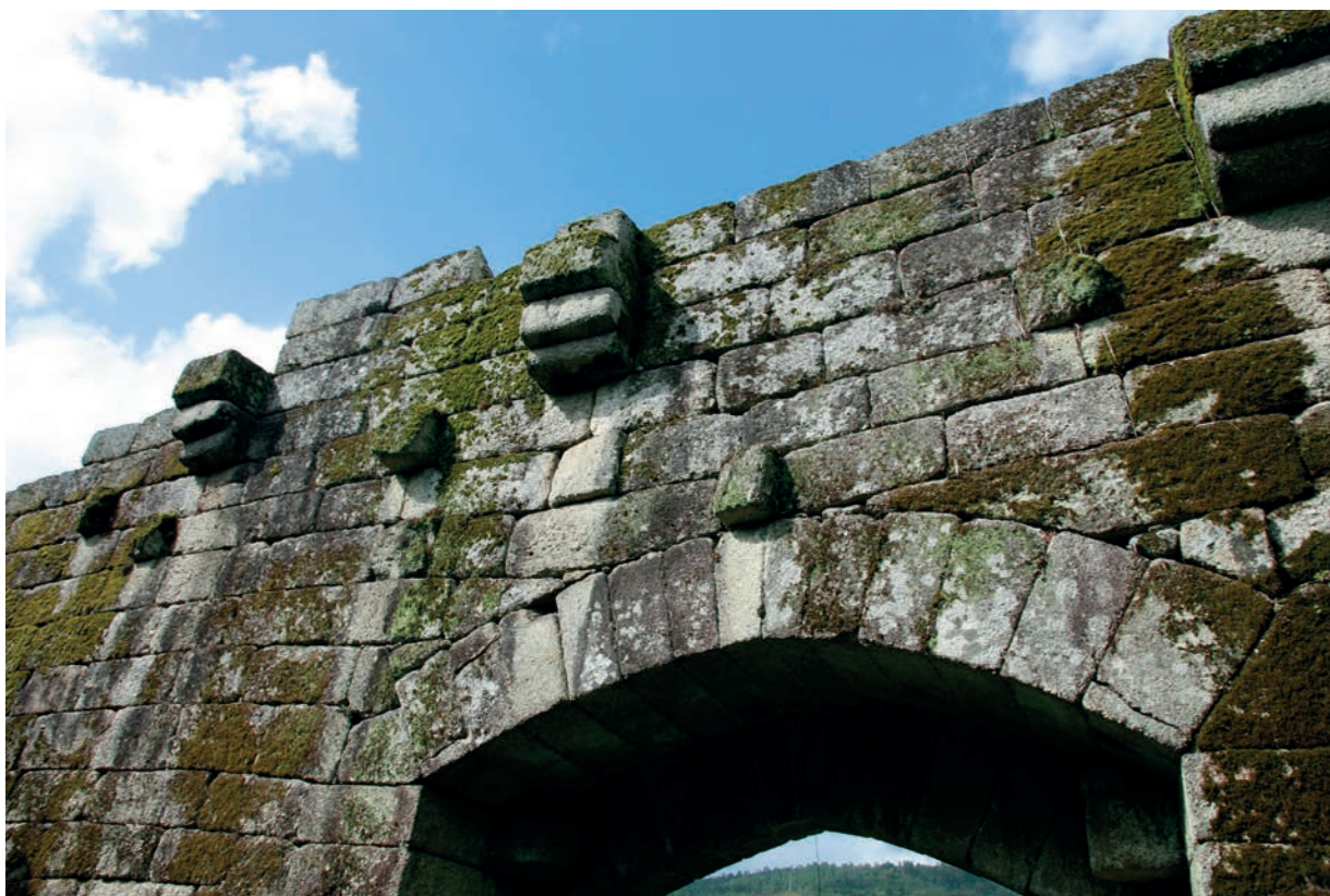
Porta de entrada (interior) e arranque dos arcos formeiros
