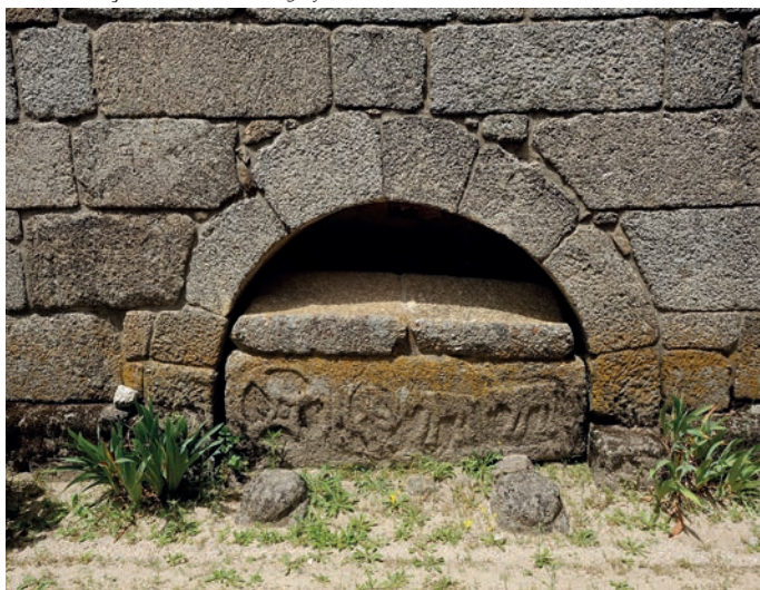
Exterior. Alçado lateral sul da igreja. Arcossólio
