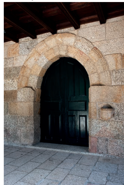
Exterior. Alçado oeste. Portal
