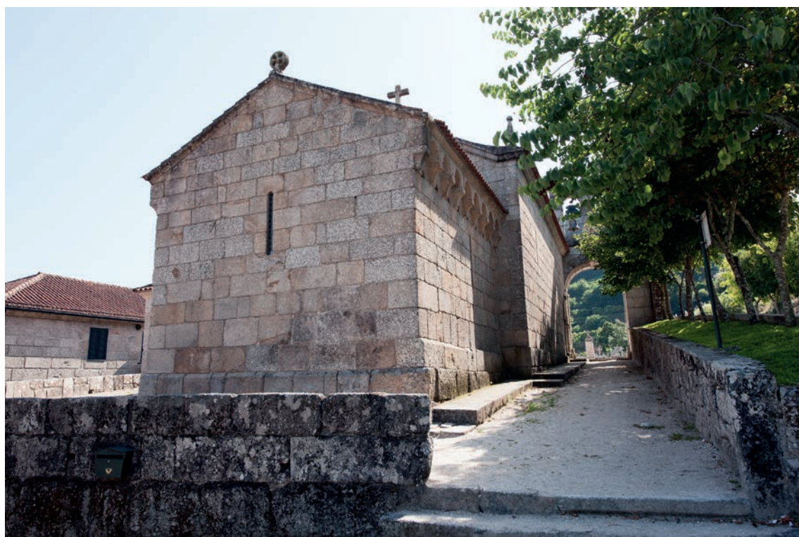
Exterior. Alçado norte. Capela-mor
