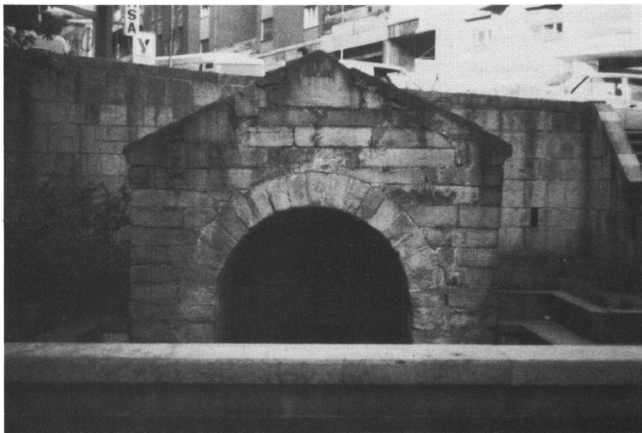
FIGURA 19.—La Foncalada (Oviedo). Situada en el centro urbano de Oviedo, esta fuente es uno de los pocos vestigios conservados de arquitectura altomedieval, en este caso asturiana, no religiosa de la época de Alfonso III el Magno. Elemento de carácter civil «sacralizado» por la presencia en sus muros de un elemento emblemático y consustancial a la monarquía asturiana: la Cruz (Fotg. Angela Crespo Espinel). Número 7. Agosto de 1992.
