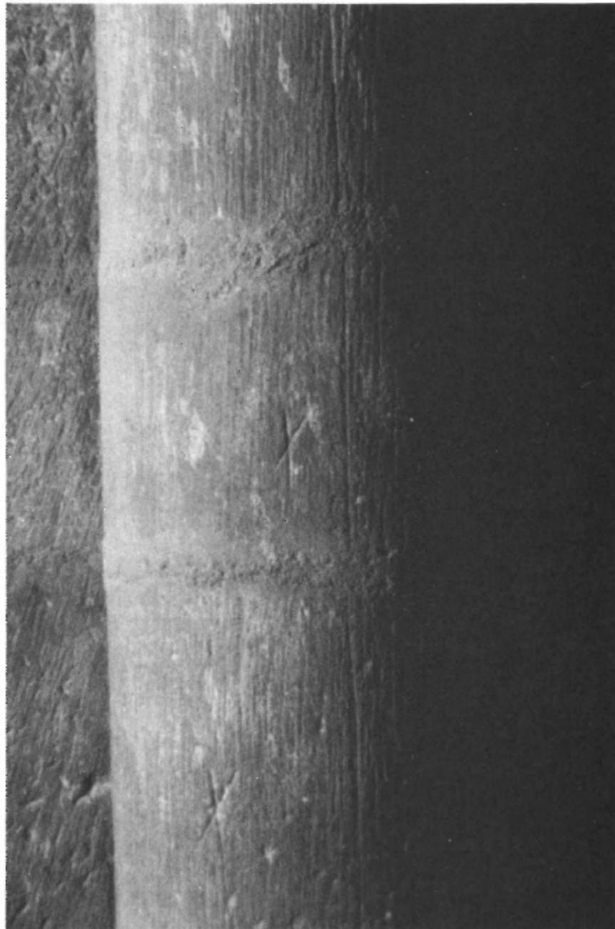
FIGURA 60.—Fuste de semicolumna de la nave principal en la que se aprecia una marca vertical para el encaje.
