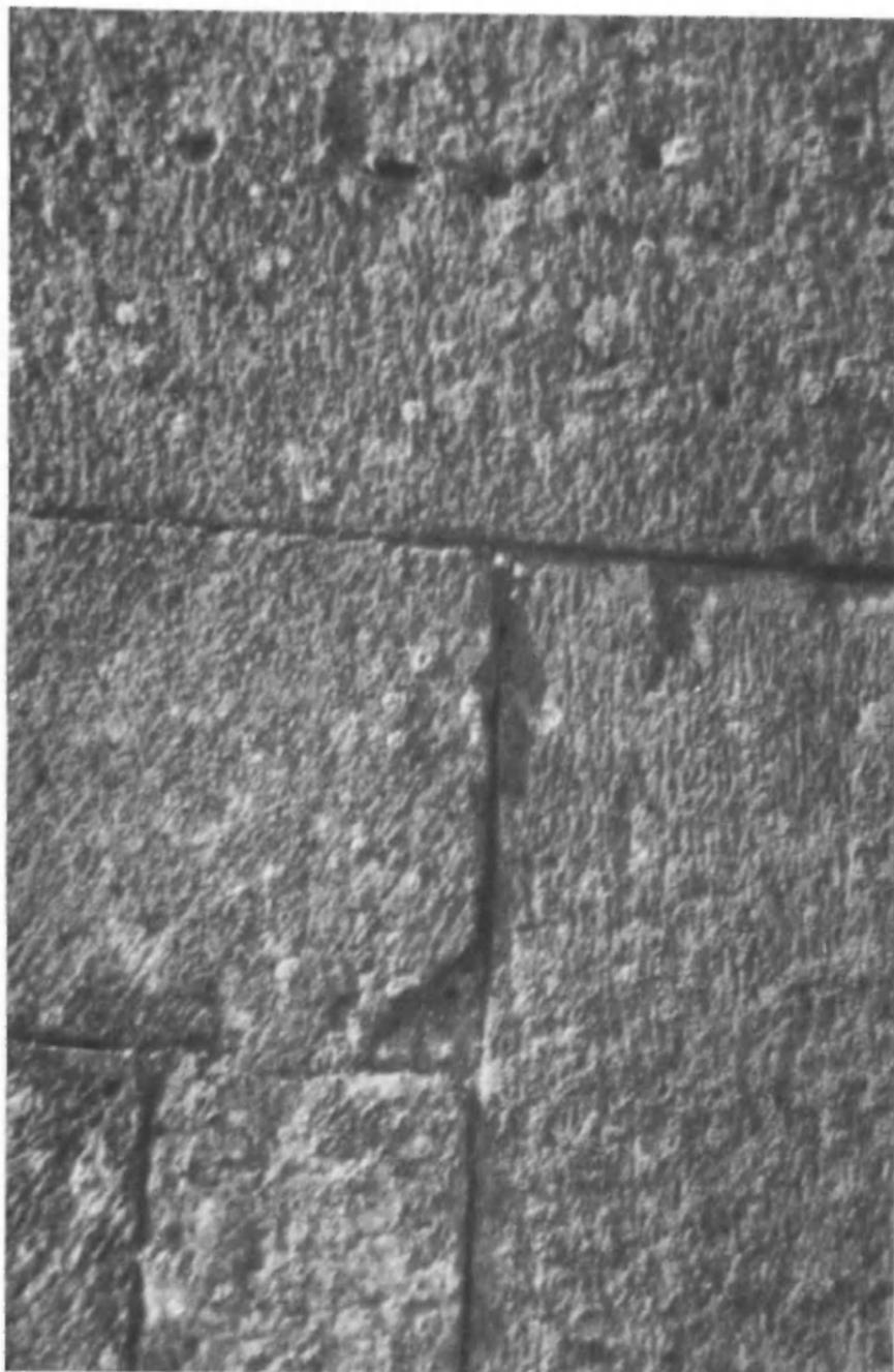
FIGURA 47.—Talla muy cuidada en los contrafuertes del ábside donde no se aprecia ninguna impronta del instrumento de trabajo.
