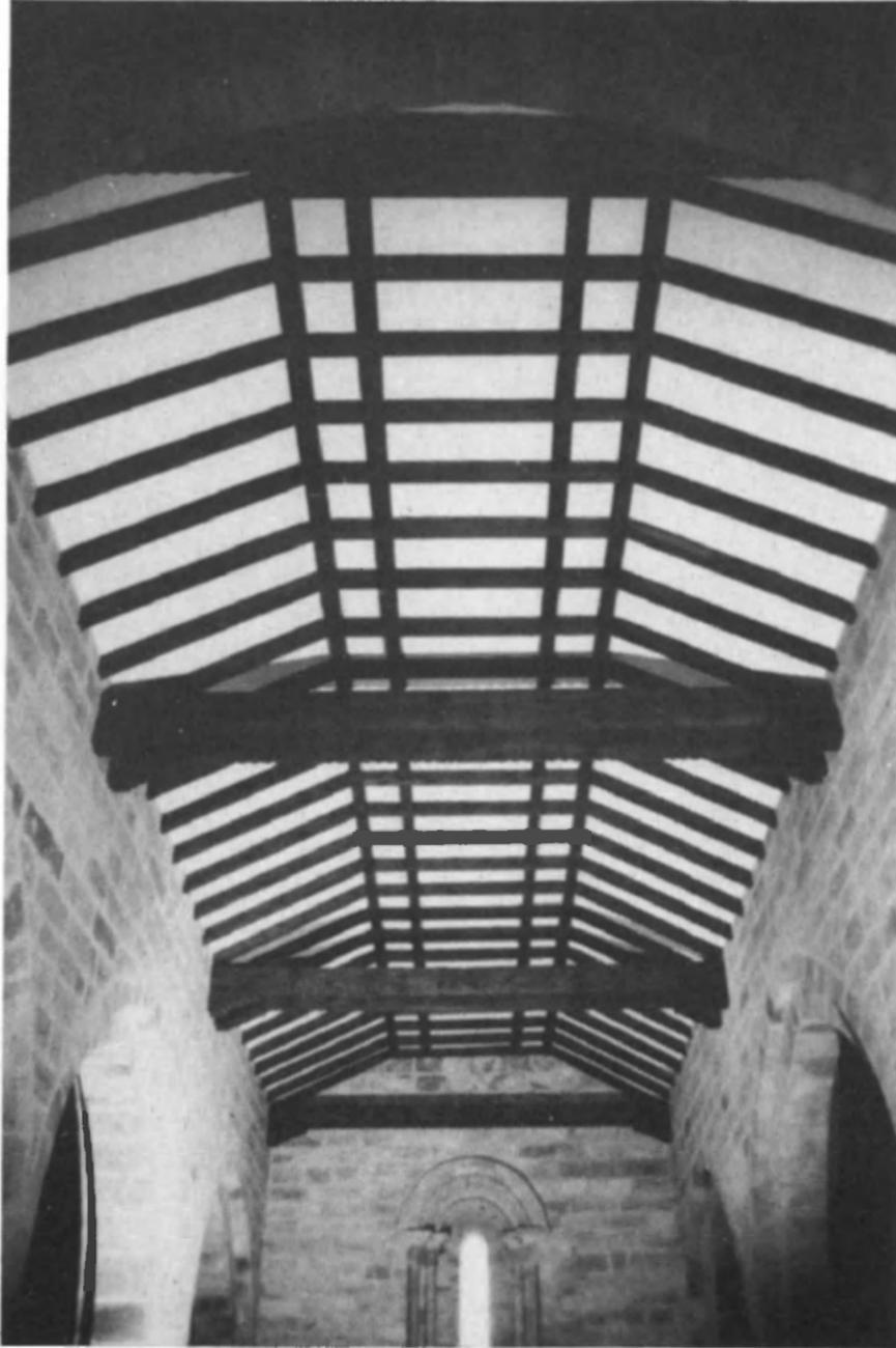
FIGURA 22.—Cubrición de madera de las naves.
